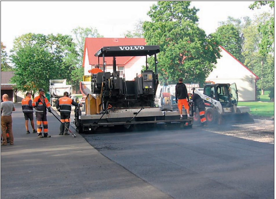
Asfalteerimistööd 2016. aasta suvel. Foto Tiit Talts
