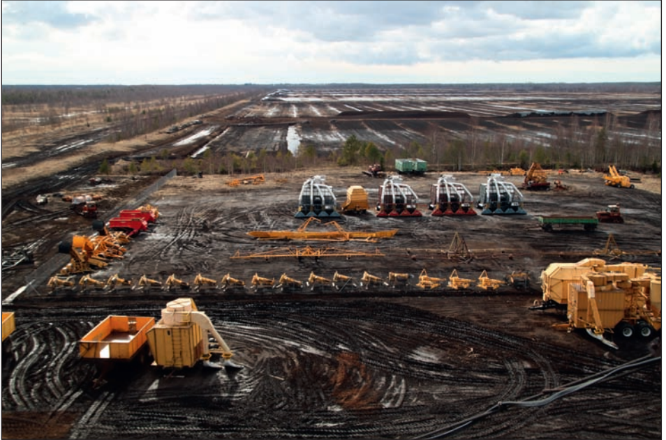
Lavassaare ja Elbu turbatootmisala. Foto Toomas Kalda
