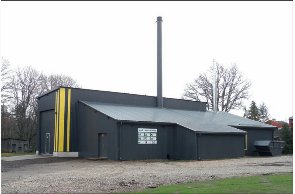
Renoveeritud Uulu katlamaja. Foto Tiiu Sommer
