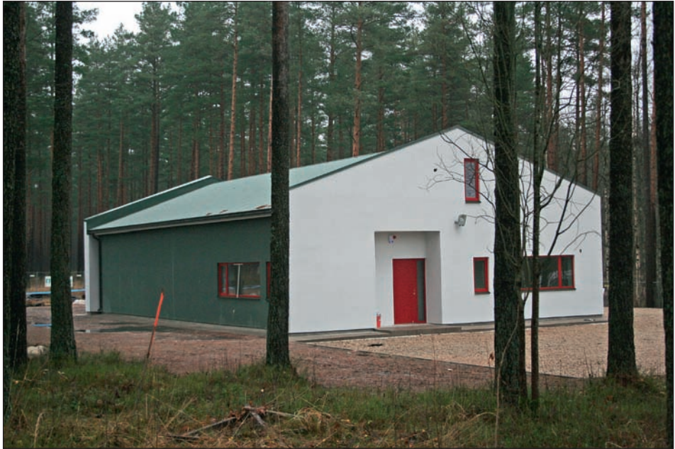
Veetöötusjaam. Foto Kalle Kiipus
