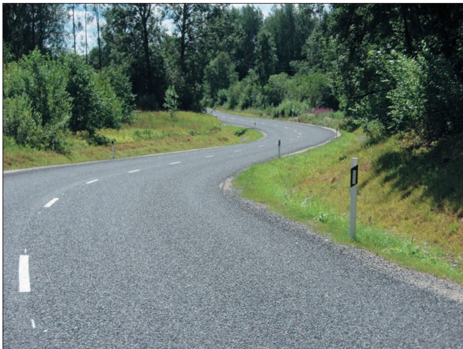
Riigimaantee nr 19301 Kilingi-Nõmme-Tali-Laiksaare km 0,9–16,9 kruusateele ehitatud tolmuva kate. Lääne regionaalse maanteeameti fotokogu.
